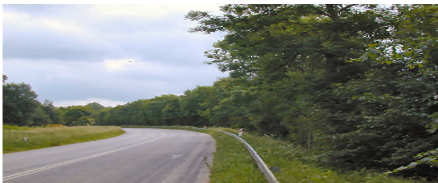
Figur 3: Levende hegn langs asfalteret vej med hurtig biltrafik.
